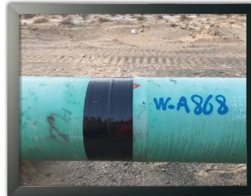
■ اپوکسی سرچوش دما بالا - پروژه احداث خط لوله ۳۰ اینچ بندرعباس/لافت/گورزین
