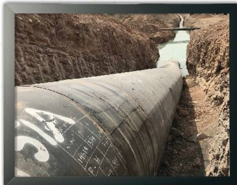
■ غلاف انقباضی حرارتی - پروژه خط لوله بندر عسلویه شرکت ایران آروین
