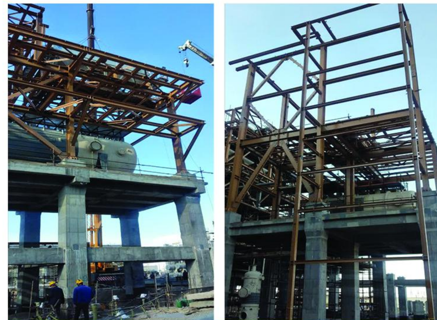
پروژه ساخت سازه فلزی گوگرد زدایی واحد RHU پالایشگاه اصفهان
