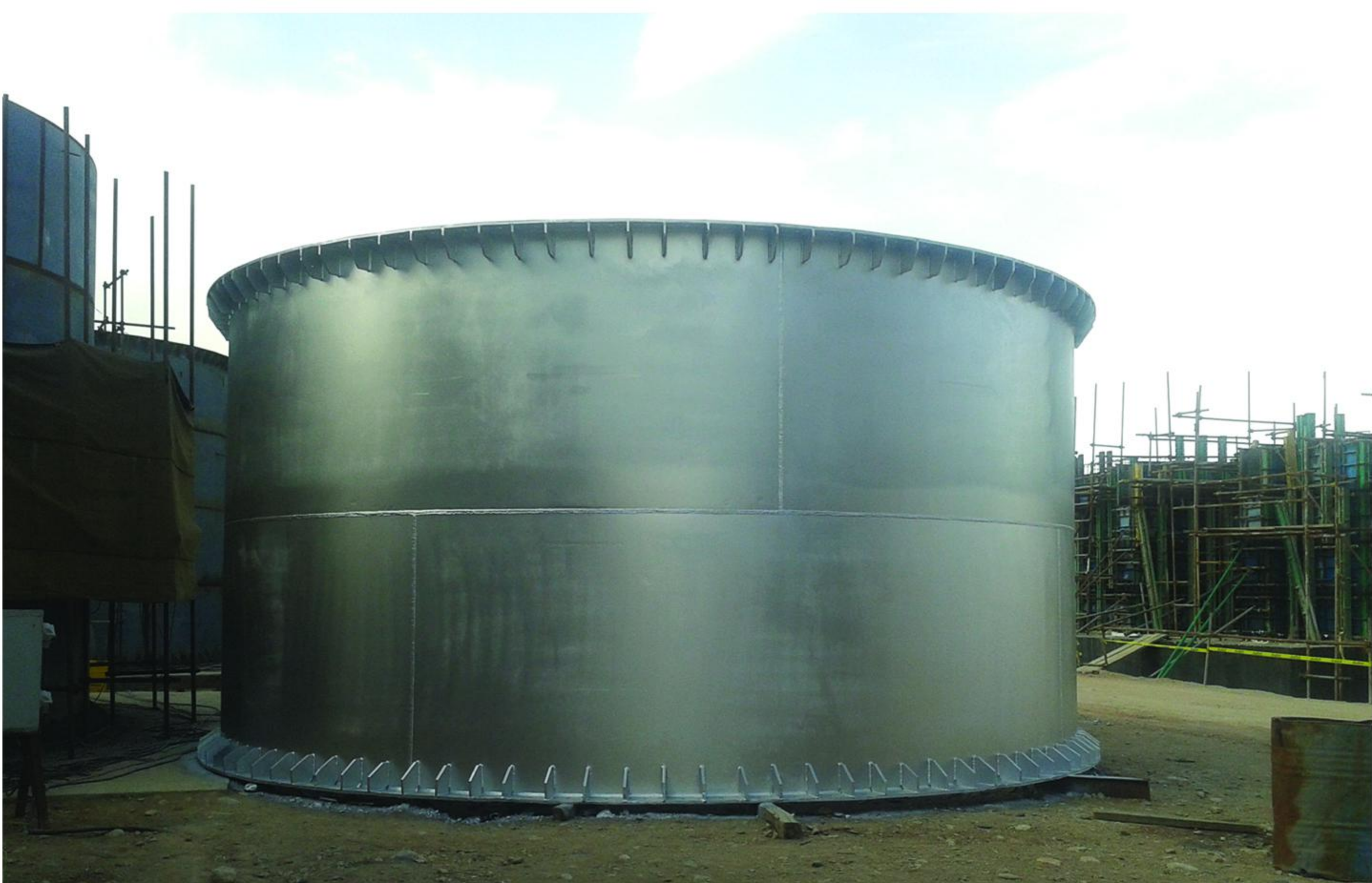
پروژه ساخت و نصب دودکش مجتمع گندله سازی سیرجان
